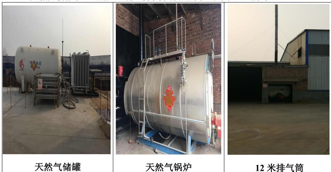
图 3-2 天然气储罐、锅炉、排气筒现场照片
